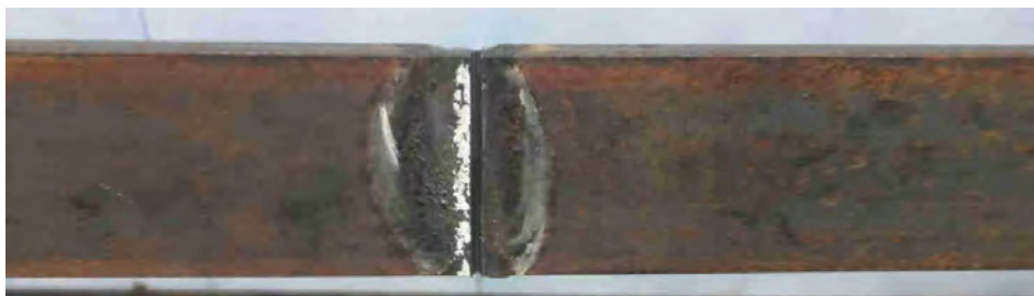
Figura 3.5.2. Bara cu defect
